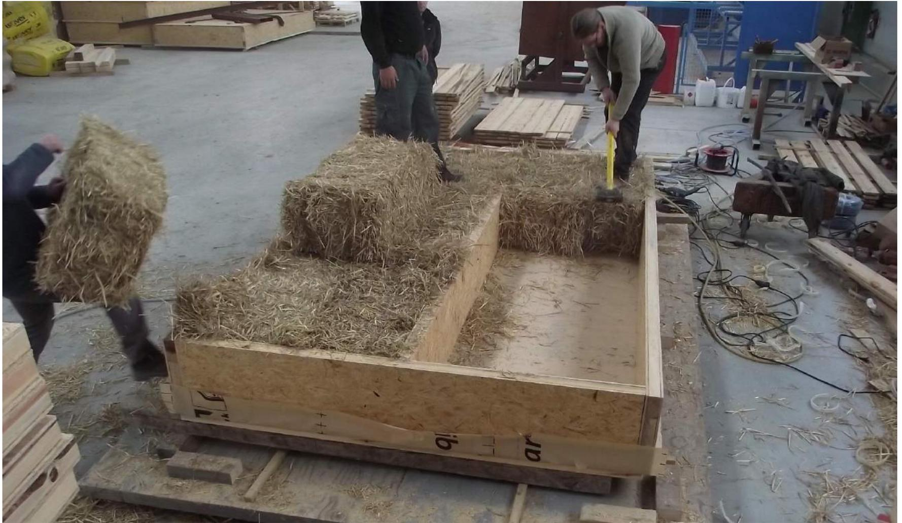
Préfabrication des caissons isolés avec des bottes de paille
